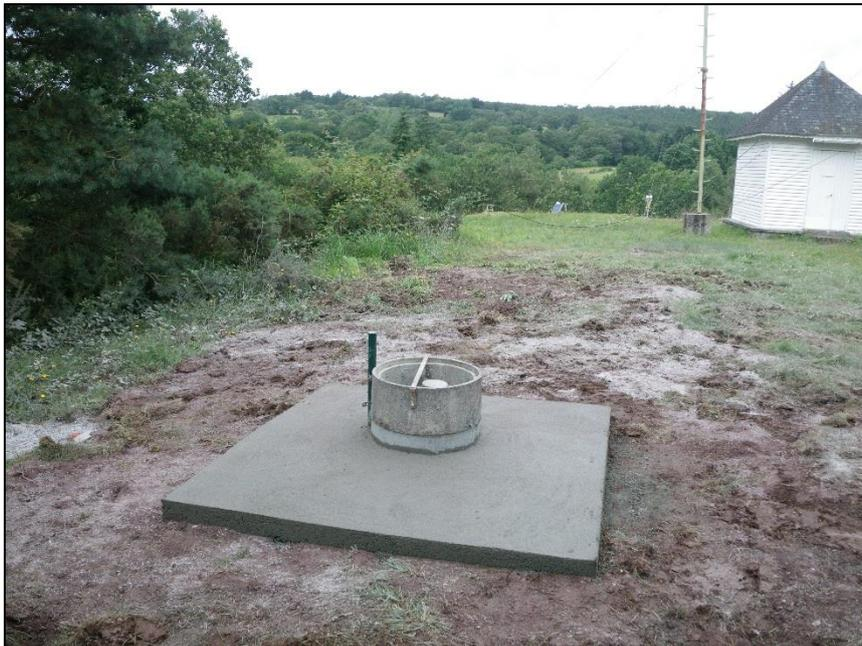
Figure 17 - Piézomètre BRGM à la Station biologique de Paimpont (source : BRGM, 2012)
