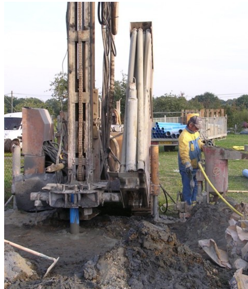
Illustration 6 : Réalisation d'un forage.
