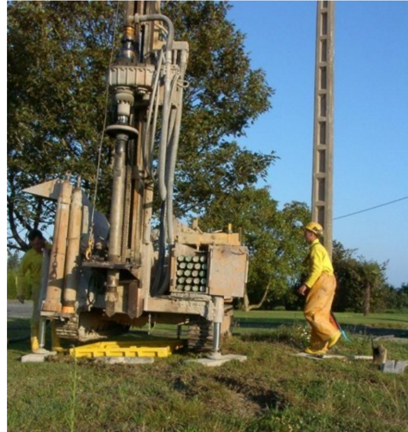
Illustration 1 : Réalisation d'un forage. Crédit : BRGM
