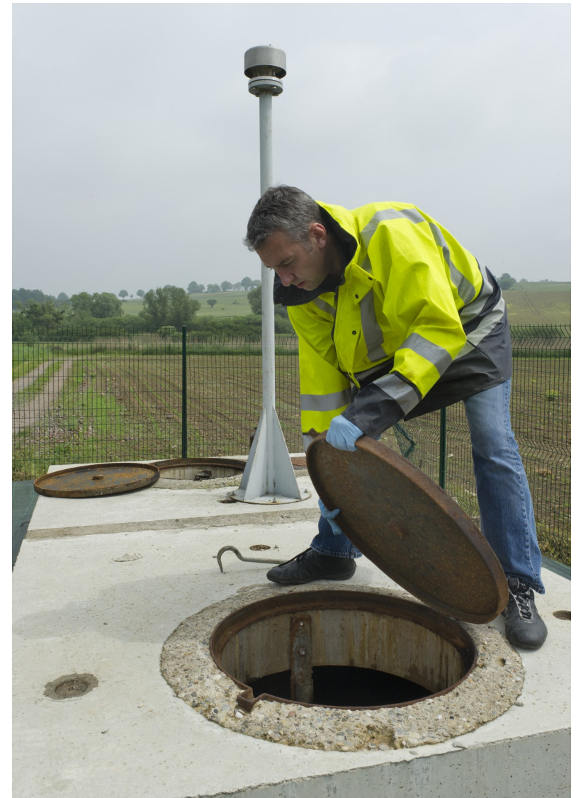
Illustration 11 : Forage équipé. Crédit : Laurent Mignaux (Terra)
