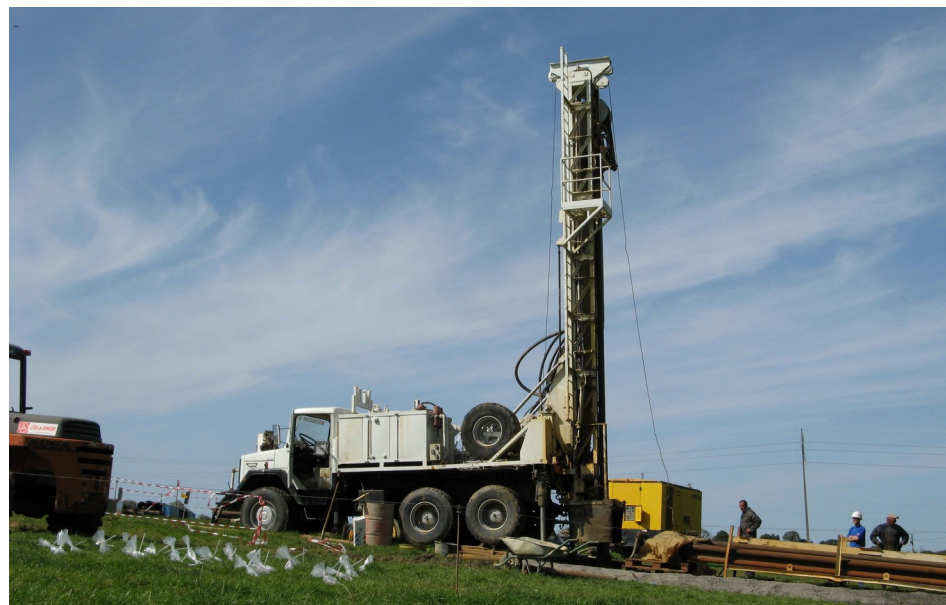
Illustration 8 : Foreuse. Crédit : BRGM
