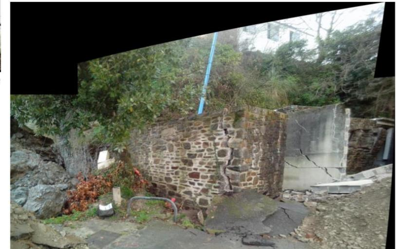
Illustration 11 : Poussée du pied de la falaise sur les sanitaires et soulèvement du bitume
