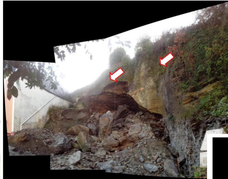
Illustration 8 : Fissures de 3 à 4 m de hauteur, espacées de 2 à 3 m et ouvertes de 2 à 8 falaise.
