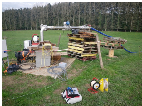
Dispositif du pompage de 9 semaines (forage F3, GHI)
