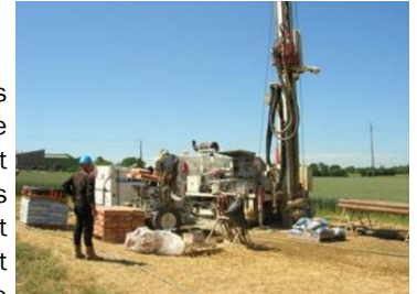
Site de Saint Brice-en-Coglès, forage carotté de 250 m (COFOR-mai-juill.2011)
