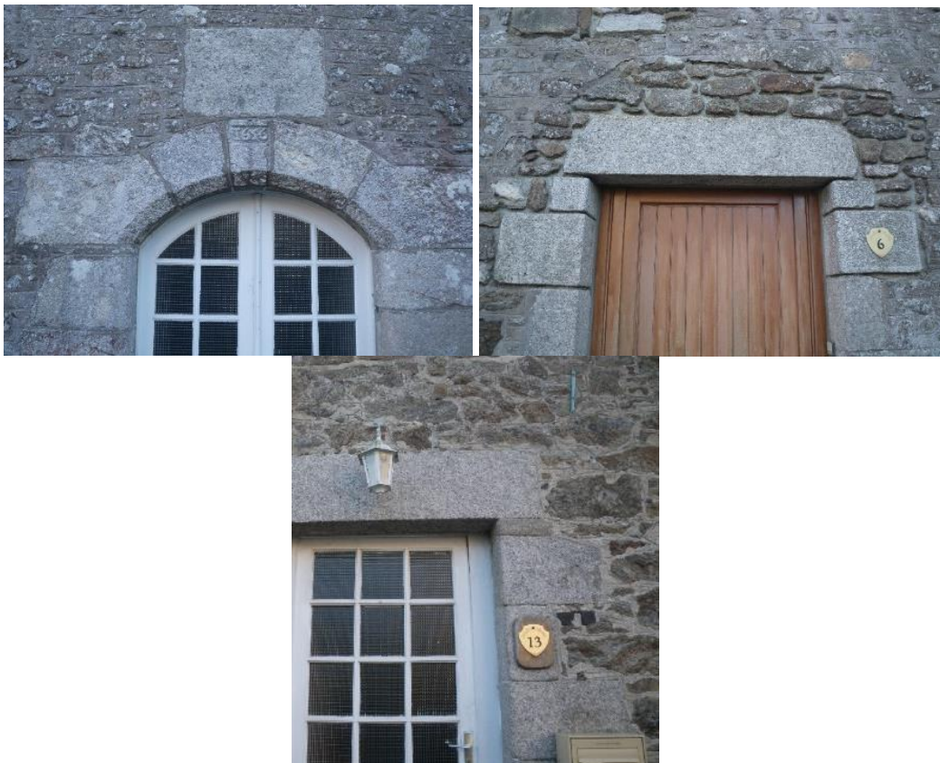
Figure 10 – En haut à gauche : linteau cintré ou arqué de granite, en haut à droite et en bas en : découpe artisanale de la partie en contact avec les pierres de pays (pouvant être 17 ème à plus récent) ou découpe droite donc industrielle plutôt 19 ème (âge de la révolution industrielle).
