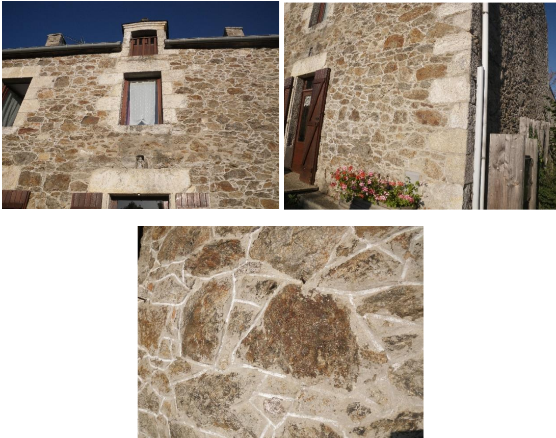
Figure 11 – En haut à gauche : Chien-assis style cancalais ou de Saint-Jacut-de-la-Mer ; en haut à droite : Pierres de structure ; en bas : Pierre de pays avec des traces d'oxydation de fer (rouille) montrant que de l'eau souterraine a circulé
