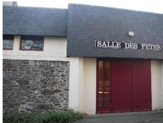
Figure 8 - Photographie de la salle des fêtes du Plessix-Balisson
