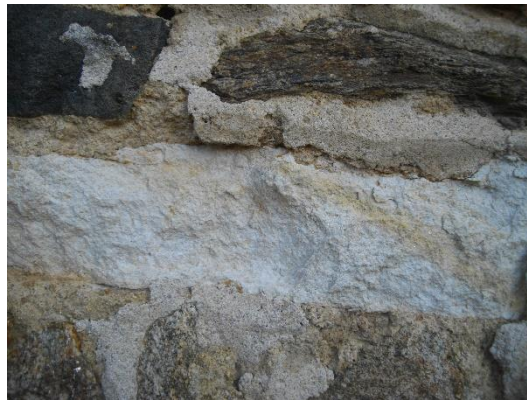
Figure 16 – Roche blanche entièrement altérée et devenue friable
