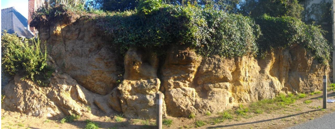
Figure 17 - Affleurement des isaltérites et de la zone fissurée du granite/gneiss altéré et fracturé à la sortie du bourg du Plessix-Balisson
