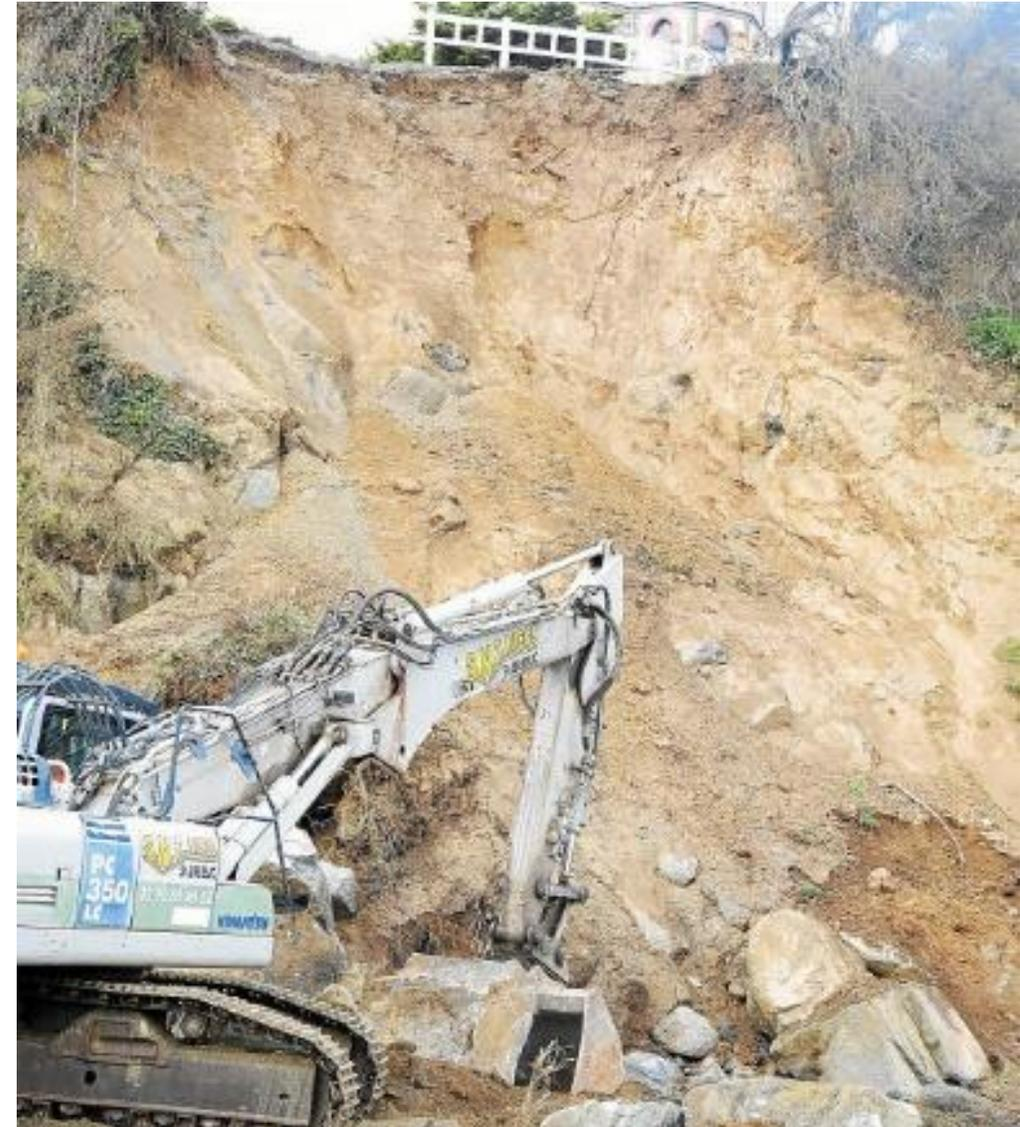
*Erosion de falaise littorale constituée d'une roche magmatique plutonique altérée (Isaltérites de diorite & gabbro, Saint-Quay-Portrieux, Côtes d'Armor 22 ; Source : Inventaire des mouvements de terrain des Côtes d'Armor (2011), Atlas des aléas littoraux (2013-2015) et Expertise des falaises de Saint-Quay-Portrieux (2018-2019)*
